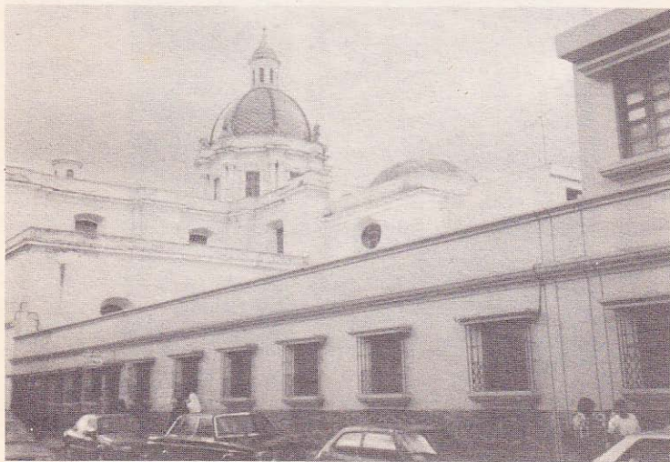
Edificio de Servicios Sociales de La Merced.
